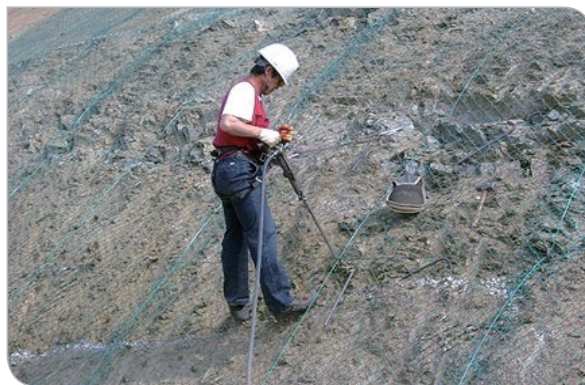
2. 양카핀,착지핀 홀천공 및 설치
